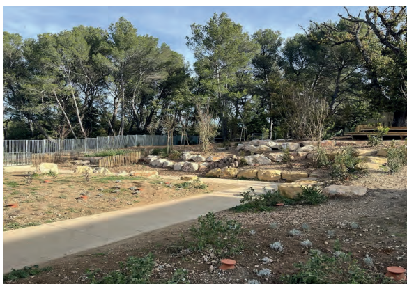
Désimpermeabilisation Cours d'école - Greasque
