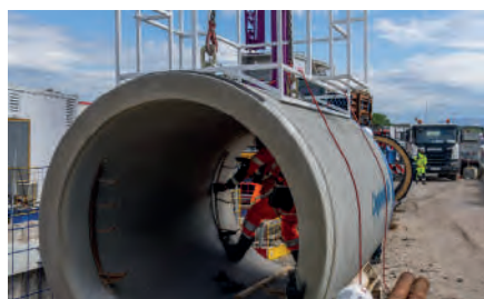
Travaux de la liaison hydraulique Marseille Nord / secteur Etang de Berre.
